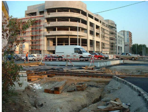
14. kép: Árkád Bevásárlóközpont építése, 2001
