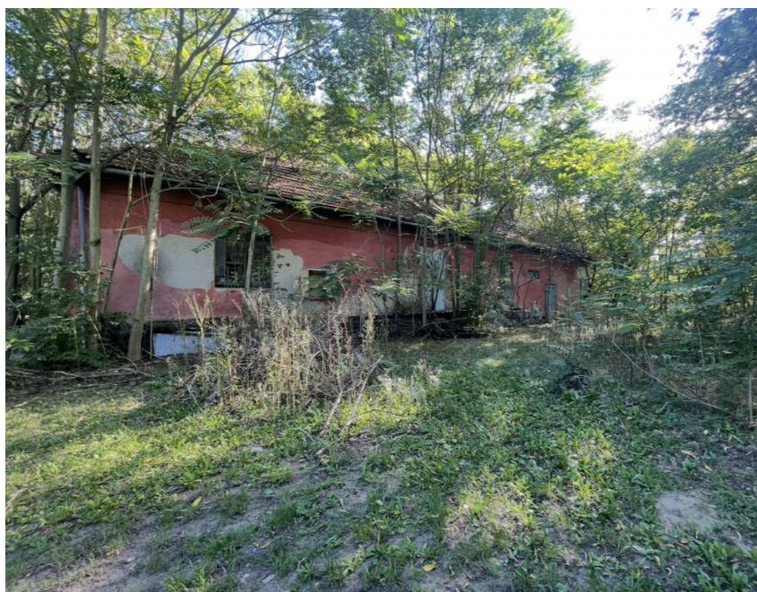
12. ábra A már "haszontalan" tejsarnok 2025.09.22. saját fotó
