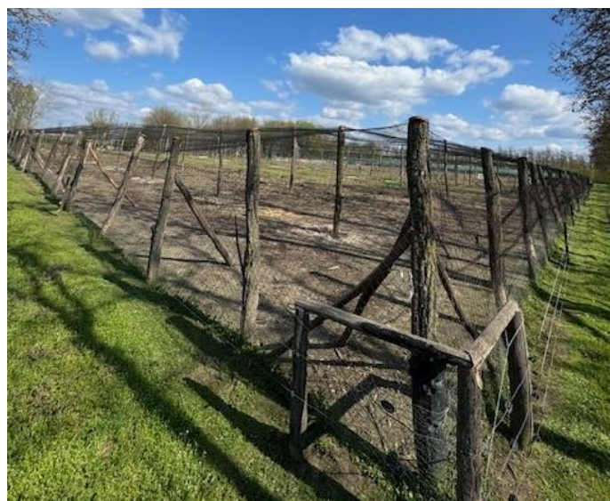
8. ábra Tartó oszlopok elhelyezkedése és merevítése
