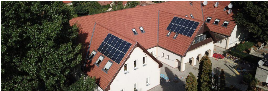
4. kép: Az iskola és az óvoda közös épülete
