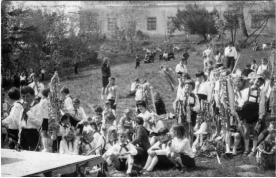
49. melléklet: Kastély a park felől, 1968-99 között (INT-07)
