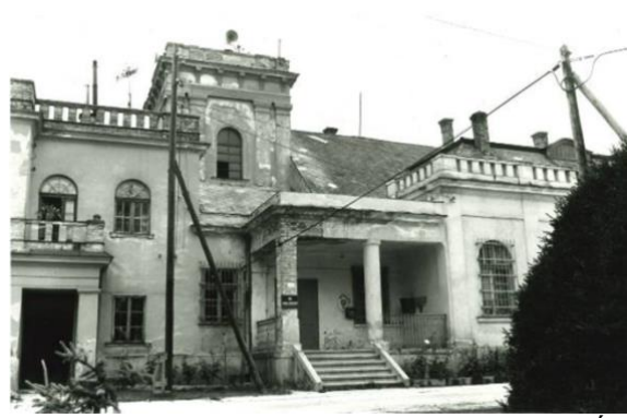
32. melléklet: Kastély felújítás előtt, 1982 (MÉM MDK Tervtár 28594)
