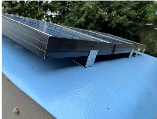
11.Ábra: Légrés a napelemek és a tető között (saját kép)
