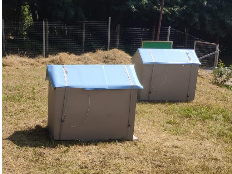
7.Ábra: Vízálló membrán rögzítése (saját kép)
