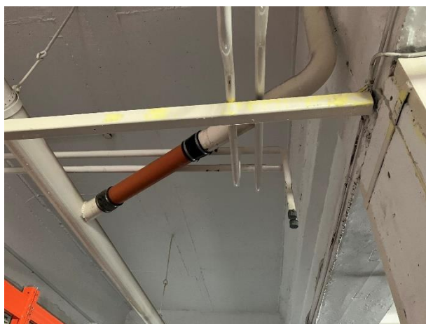
5. ábra Javított csőszakasz (Forrás: saját kép)
