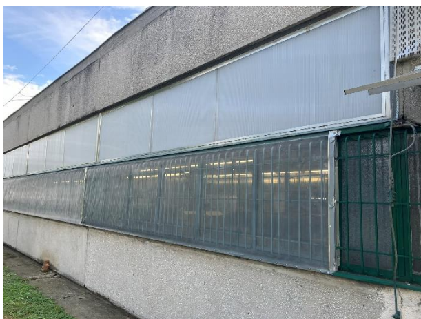
4. ábra A kopolit üveg helyettesítése polikarbonát lemezzel (Forrás: saját kép)
