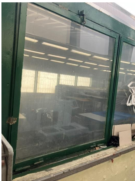
3. ábra Az eredeti fémkeretes nyílászáró (Forrás: saját kép)
