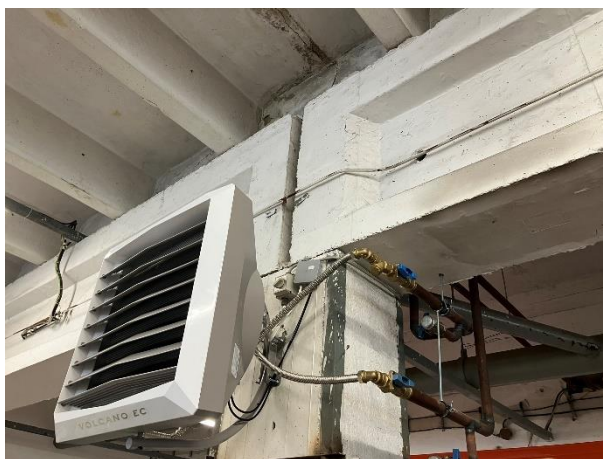
8. ábra VTS Volcan VR Mini EC (Forrás: saját kép)
