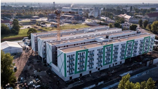
7. ábra Gubacsi úti munkásszálló
