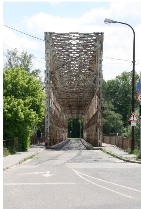
1.ábra: K-híd és Óbudai-sziget (saját fotó)
