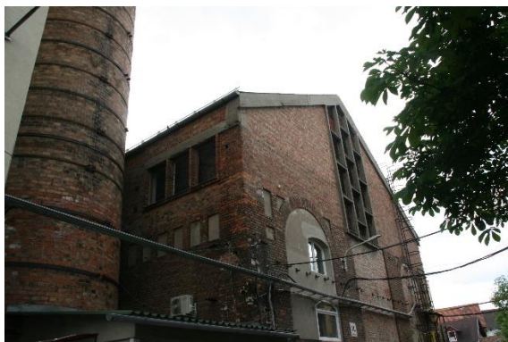
20. ábra: Textilgyár védett épületrésze (saját fotó)
