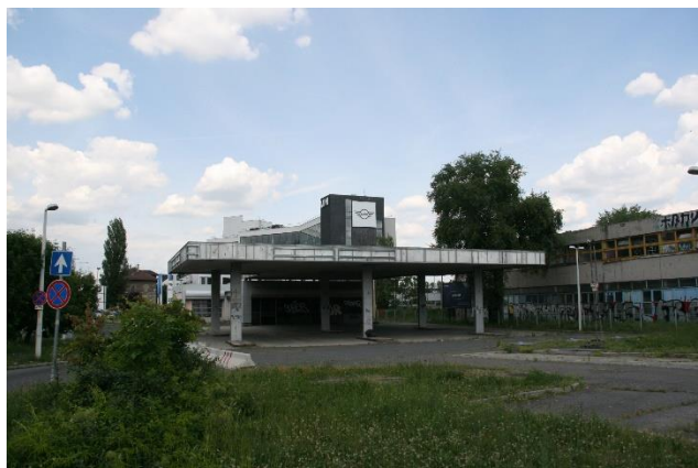
19. ábra: Bezárt benzinkút és környezete (saját fotó)
