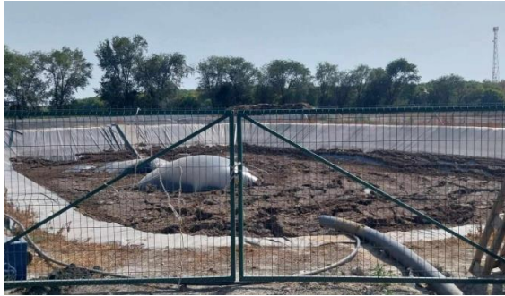
5. ábra: Hígrágya tároló (saját kép)
