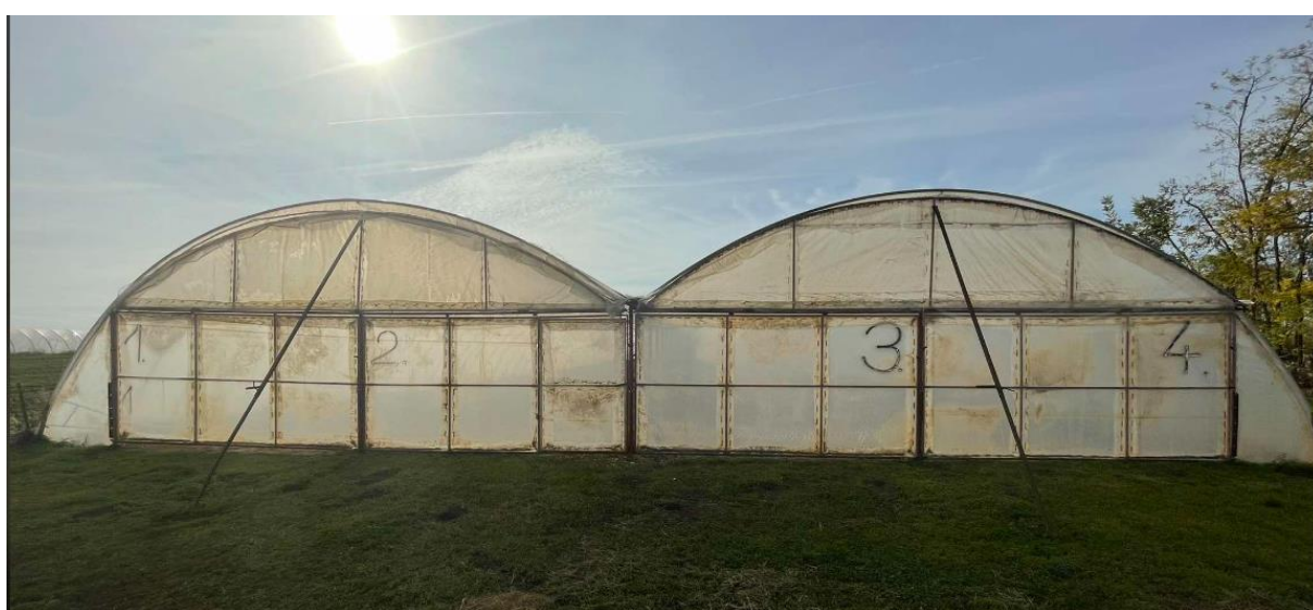
12. ábra: A burkolni kívánt felület (Forrás: Saját kép)
