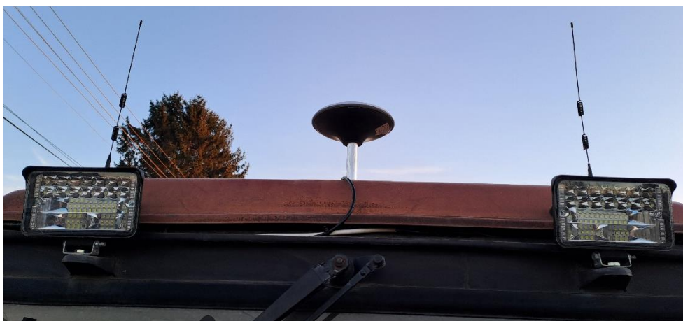
10. ábra Antenna és router erősítők felhelyezése a tetőre (Forrás: Saját kép)
