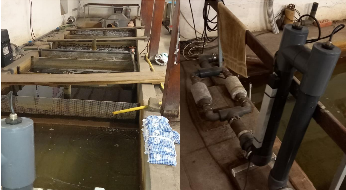
7. és 8. kép: Szűrőrendszer és a nyomó ágra szerelt vízmágnesezők és UV-szűrő. (Saját felvétel.)
