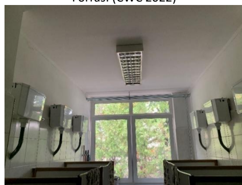
Az öltöző WC-helyisége a 6 db WC-tartállyal, amelyeket az egy rendszerben gyűjtött szürkevízzel és esővízzel töltenek. Ha nem áll rendelkezésre készenléi víz, akkor a tartályokat a hálózati víz tölti. (Forrás: saját kép)
