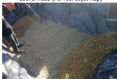
Szűrőmező kialakítása az elosztó és gyűjtő részen nagyobb szemcseméretű zúzalékkal. (Forrás: Hidro-Consulting Kft)
