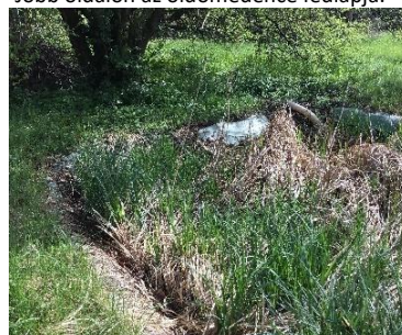
A szűrőmező HDPE-fólia szigetelése.
