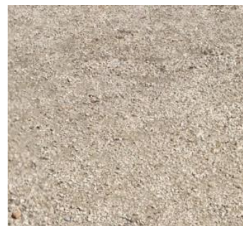
28. ábra: mésztejjel stab. szórt burkolat
