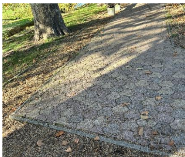
26. ábra: térkő burkolat
