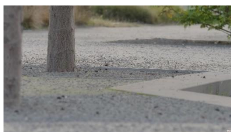
30. ábra: mech. stab. szórt burk.
