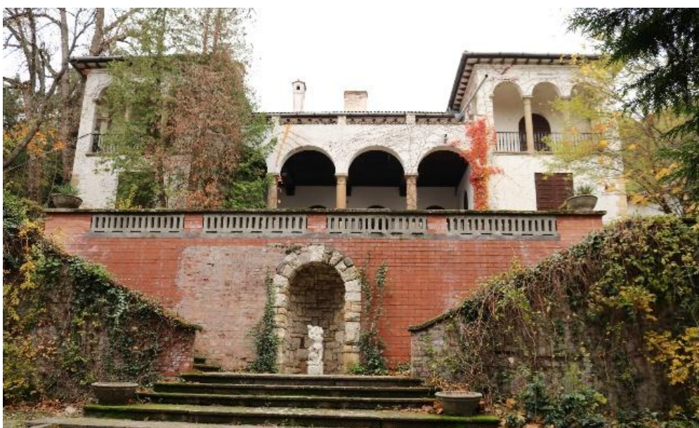
7. ábra: Villa főhomlokzata, a felvezető lépcső felől (forrás: Sárospataki Máté)
