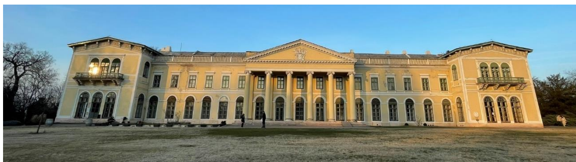
28. kép: Károlyi kastély főhomlokzata, 2024
