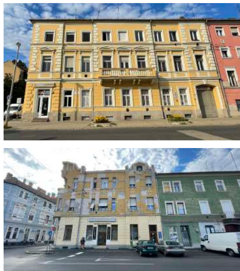
15. ábra: Bartók tér 4. és Attila utca 11. épületei (Forrás: saját kép)
