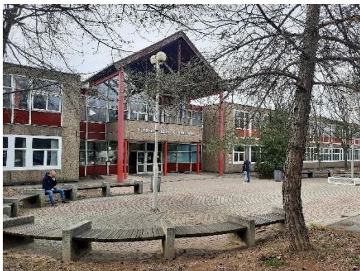
3. Az iskola főbejárata (saját készítésű fotó 2024)
