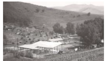
A Suvadás Liget-i presszó építése előtt az egykori vizesblokkal Forrás: https://www.arlo.hu/arlrtrnete , 2024
