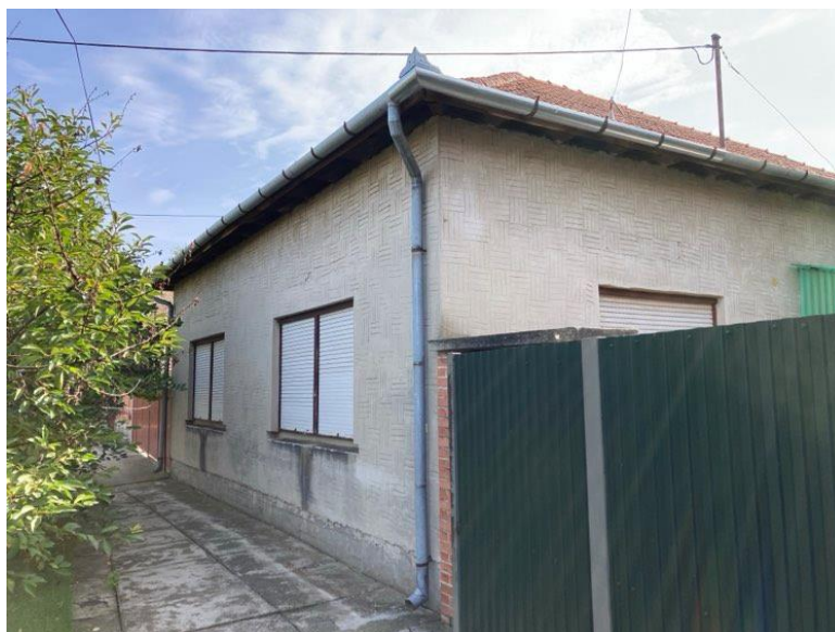
25. ábra - Az épület utcafronti homlokzata
