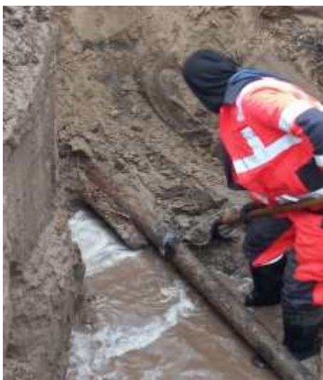
31. ábra: Fa gyökere okozta csőtörés helyreállító munkálatai (Forrás: Saját fotó (2024))
