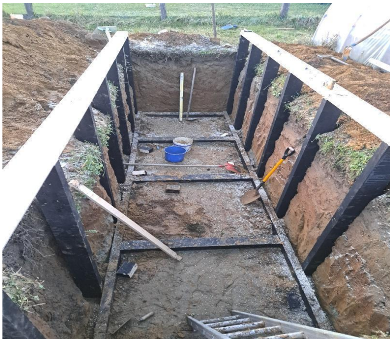
11. ábra: Tartóoszlopok megépítése (Foto: Tarné B. Á.,2023)
