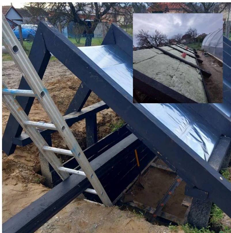
13. ábra: Alu hőtükör fóliázás és szigetelés (Foto: Tarné B. Á.,2024)
