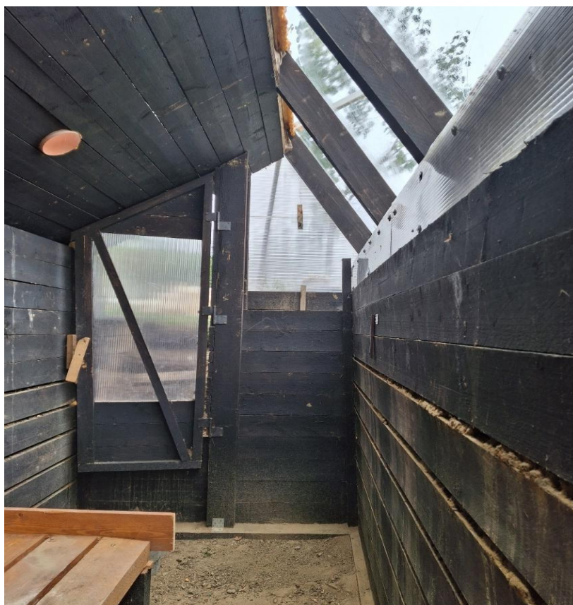
15. ábra: Az ajtó polikarbonát lemezzel való fedése (Foto: Tarné B. Á., 2024)
