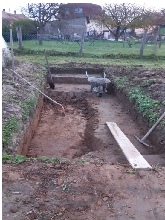
9. ábra: Walipini alapjának ásása (Foto: Tarné B. Á.,2023)
