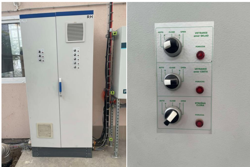
19.Ábra: Szellőztető berendezés, mechanikus kapcsolókkal (forrás: saját kép)
