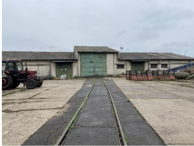
11. kép: 3.-as raktárépület vasúti kapu Hajdúszoboszló, 2023
