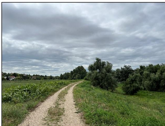
3. kép - Nóra sétány árvízvédelmi gáton végig húzódó útja (saját fotó)
