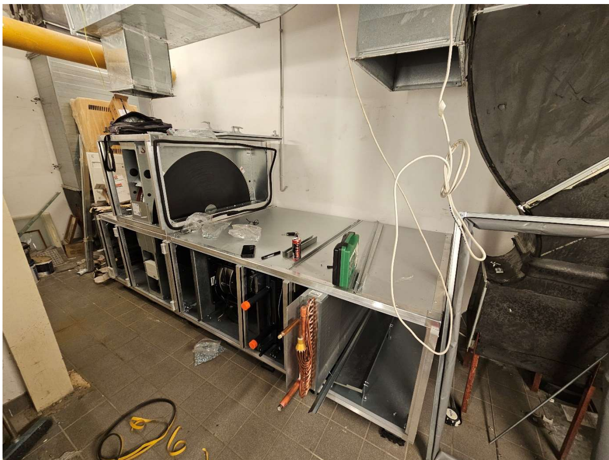
7. ábra: VTS légkezelő a Vénusz Galériában összeszerelés közben (Forrás: Saját forrás)
