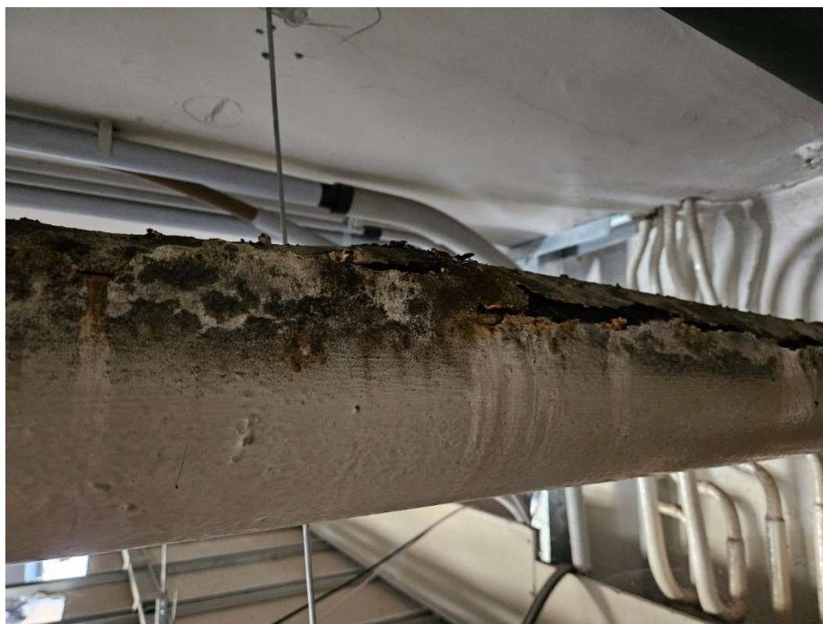
10. ábra: Elöregedett társasházi szennyvíz vezeték (Forrás: Saját forrás)
