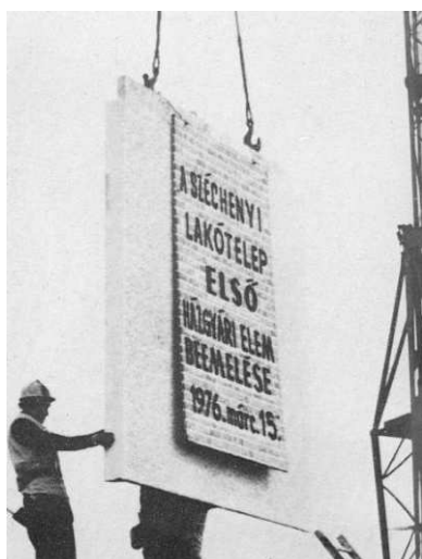
2.Kép Első házgyári elem beemelése (Forrás: INT-02)
