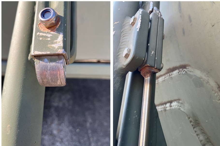
22. ábra A HT 51-96 hatósági jelzésű ÜTG-18 feljárólétra rugós rögzítő retesze két nézetből. A retesz felhajtott állapotban rögzíti a létra alsó felét a felső félhez. Az acél alkatrészekon korrózió látható, kenőanyag nincs a súrlódó felületek között, a retesz házáat a feljárólétrához rögzítő hatlapfejű csavar rövid, a csavarkötést alátét nélkül, önbiztosító hatlapú műanyagbetétes anya használatával próbálták létrehozni úgy, hogy az önbiztosítás a csavar rövidsége miatt létre sem jön (forrás: Saját felvétel)
