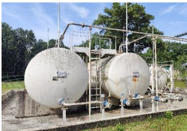
4.6. kép Fáradtolaj és tartálytisztítási maradék gyűjtés központi gyűjtőhelyen
