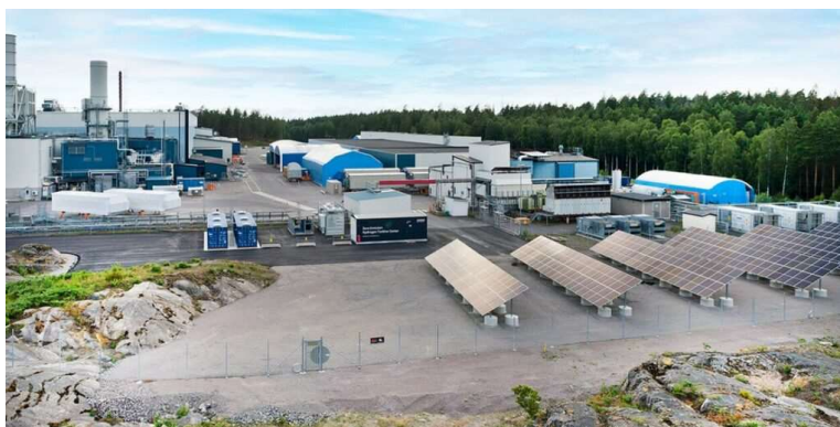
3. ábra Hidrogén alapú erőmű (kísérleti)
