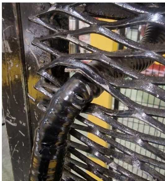
19. ábra Kábel átvezetés, sérült védőcső
