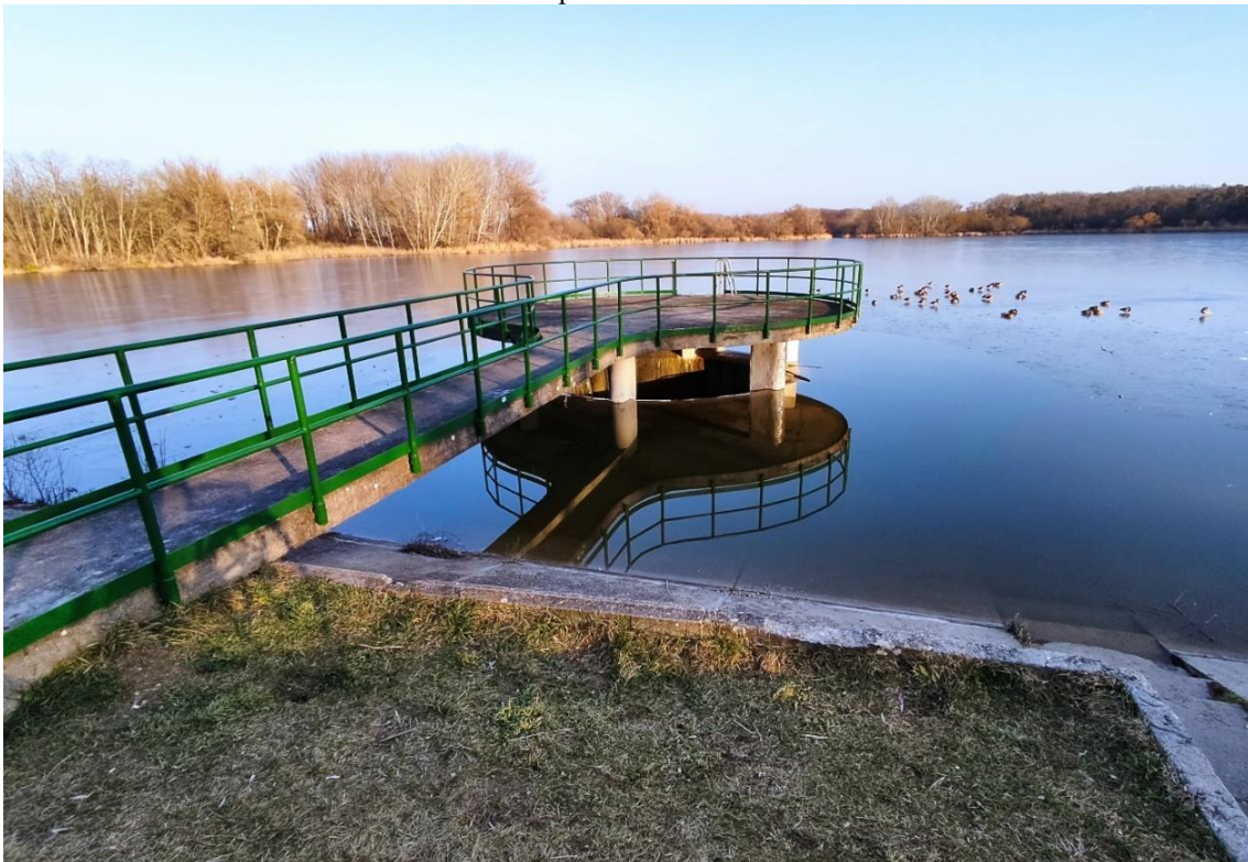
5. melléklet: Naplás-tó túlfolyó befolyó fotó: Kárpáti Barnabás Farkas
