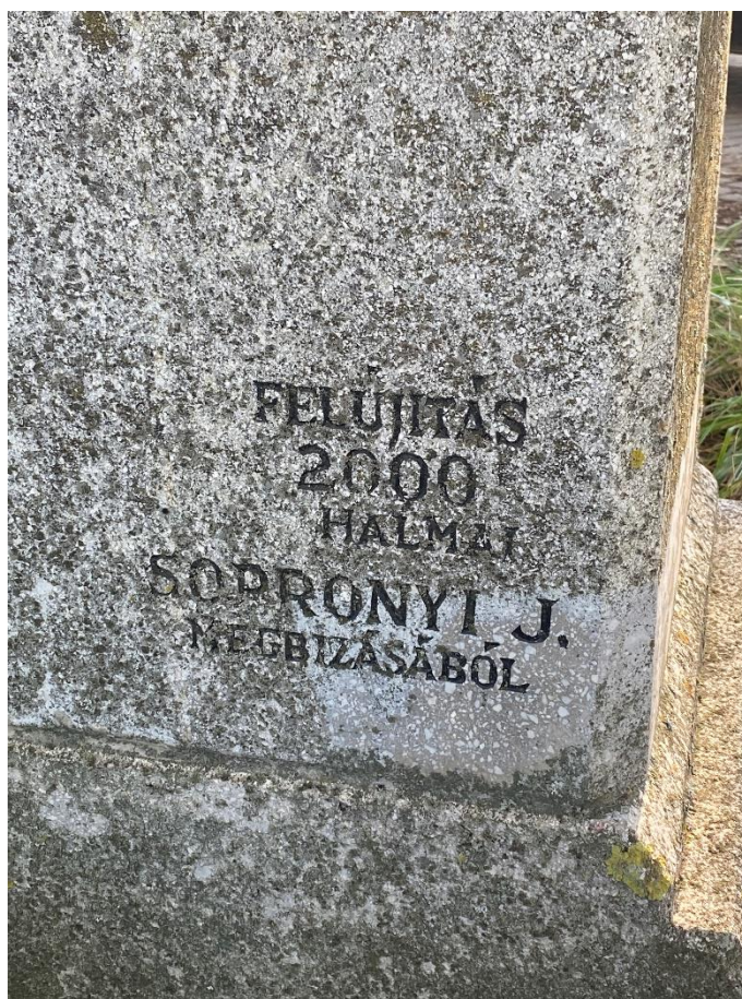
8. melléklet: Garancsi-kereszt felújítása 2000 forrás: saját kép
