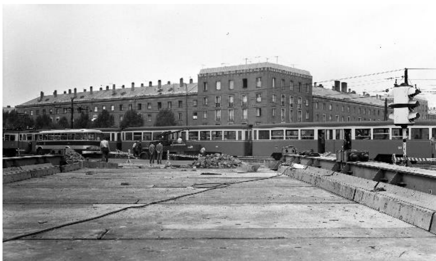
7. ábra Örs vezér tere, aluljáró építése, háttérben BHÉV szerelvénnel
