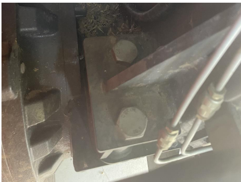
6. kép Rögzítési pont (Forrás: saját kép)
