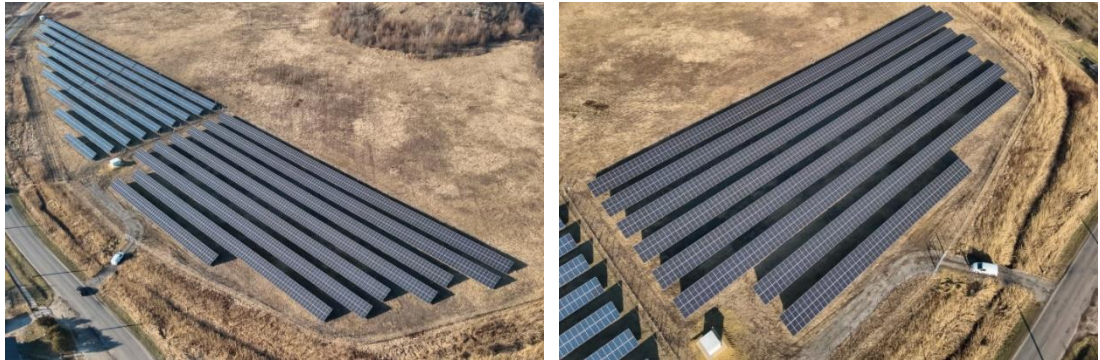
22. ábra: Telepítés utáni képek 2020 november, Kurityán, Forrás: https://villanyautosok.hu/
