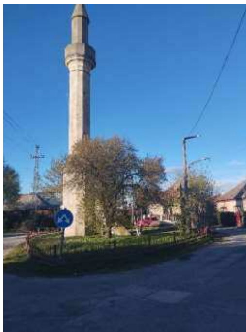
14. ábra Minaret jelenlegi állapot
