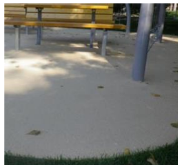
Stabilizált szórt burkolat- Stabilizer
