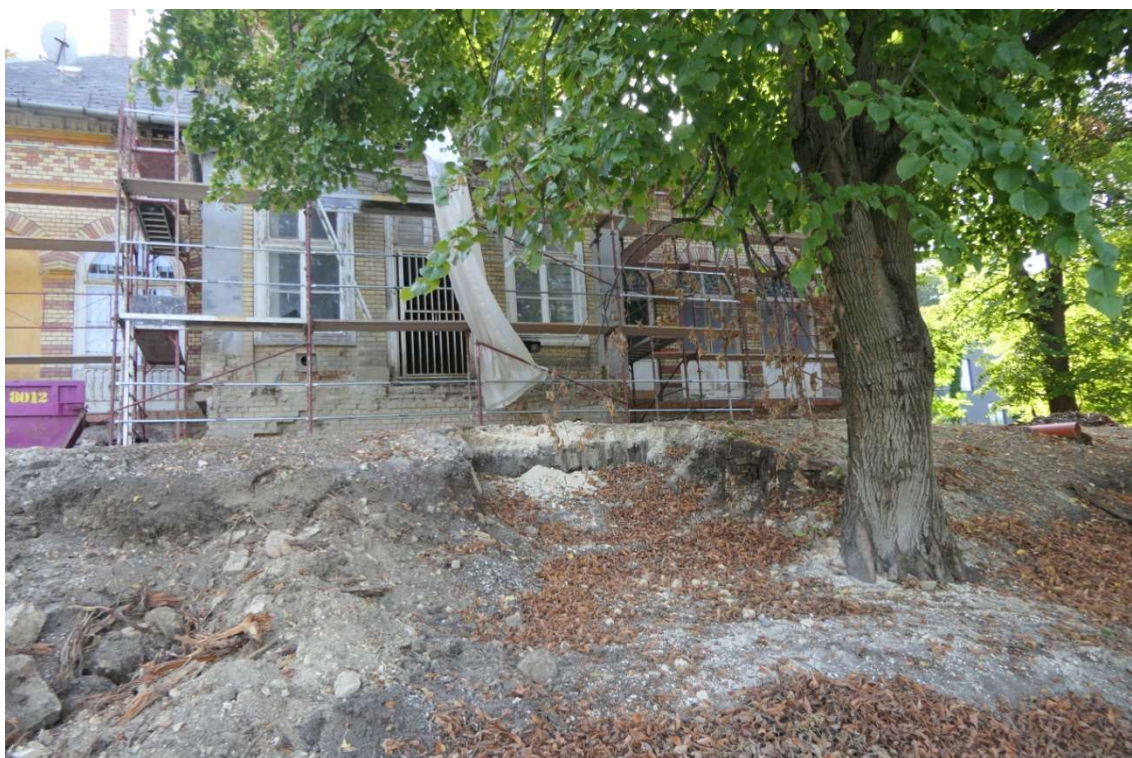
25. ábra: A villa elől elbontott teraszhoz vezető lépcsősor helye a nagylevelű hárslé töve mellett. (HNG, 2022.08.25.)
