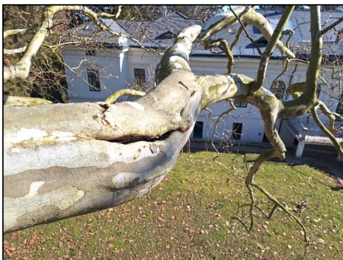
8. ábra: repedés a keleti ágrendszer végén
