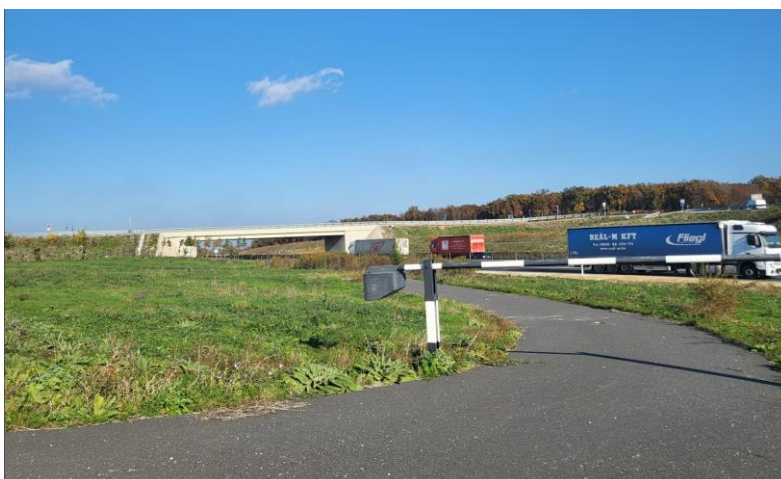
8. számú főút, Várpalota elkerülő szakasza, 2024.06.22.
