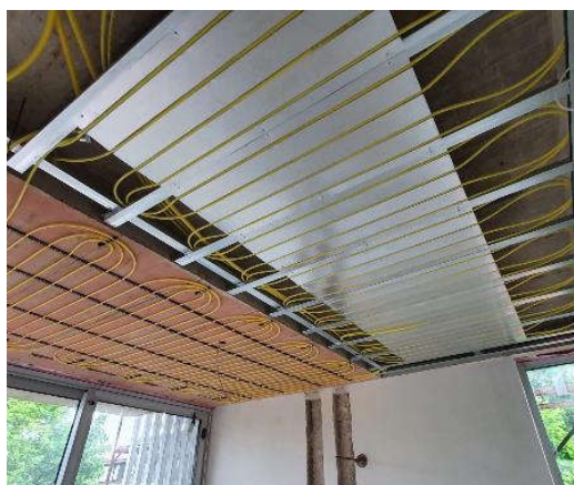
20. ábra: Álmennyezet hűtés kialakítása (Forrás: qualitherm.hu, 2022)
