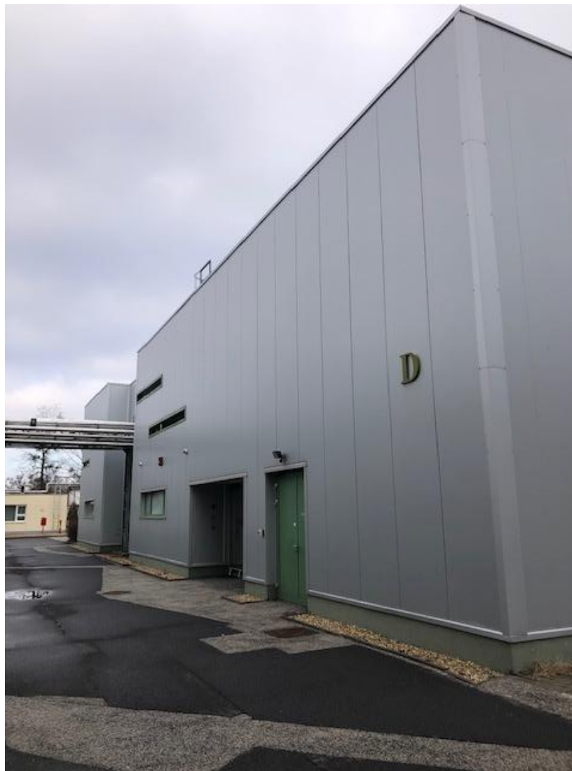
1. ábra D épület - laborház
