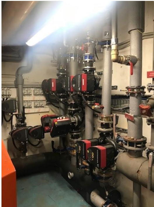
16. kép Kicszerelt szivattyúk
