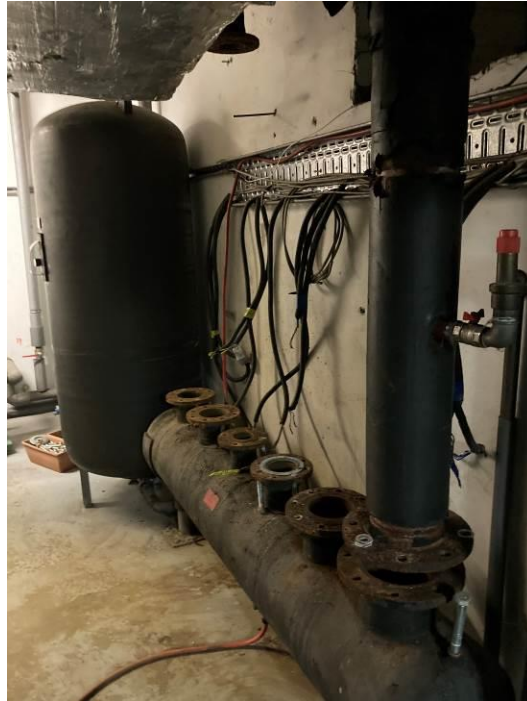
15. kép Elbontott szivattyúk
