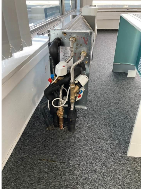
13. kép új fan coil berendezések gépészeti bekötése
