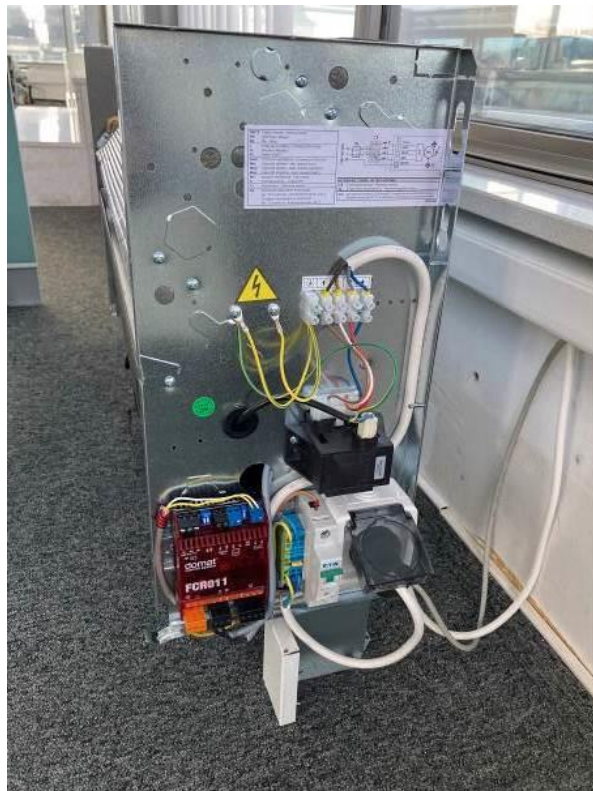
12. kép új fan coil berendezések elektromos bekötése
