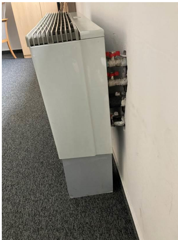
5. kép VAC típusú fan coil bekötése
