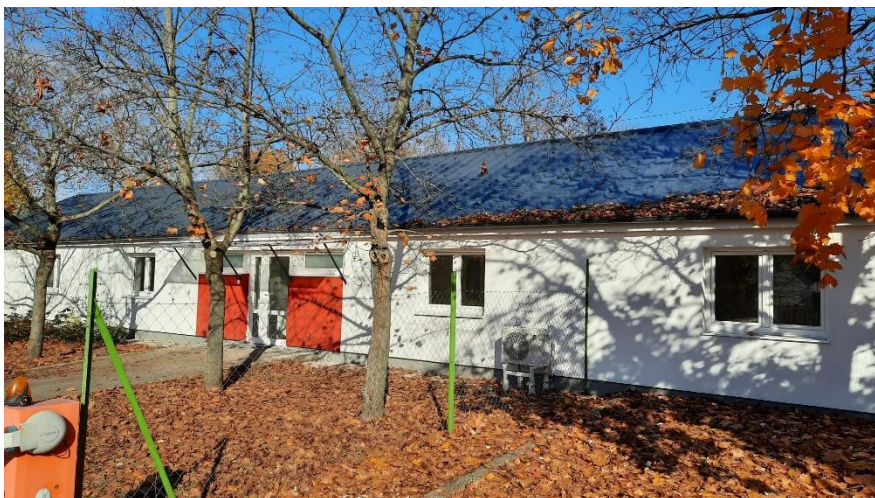
7. fénykép, Ferihegyi út porta épület, Forrás: saját készítés
