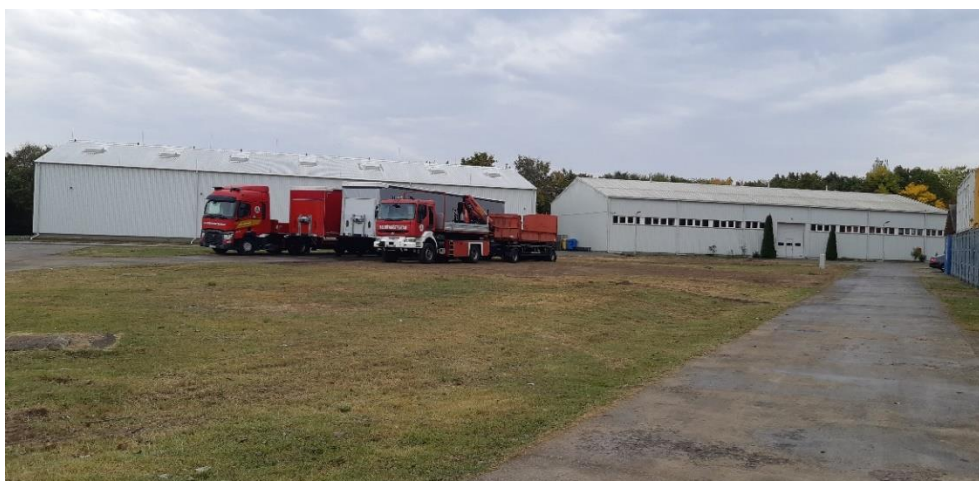
8. fénykép, Ferihegyi út Raktárcsarnok, Forrás: saját készítés
