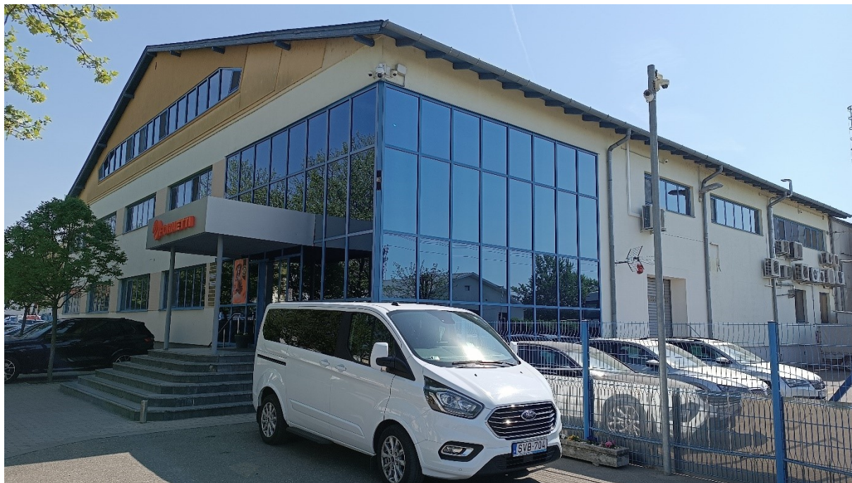
1. fénykép: A Fornetti Kft. irodaházának főépülete reflexiós üvegezéssel (Forrás: saját felvétel a Fornetti Kft. engedélyével)
