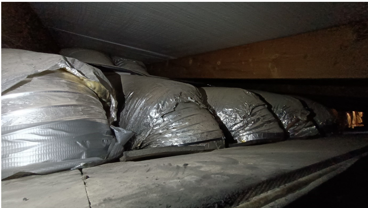
6. fénykép: Légvezetési rendszer csatlakozása a légkezelőhöz, nem légtömör csatlakozások (Forrás: saját felvétel a Fornetti Kft. engedélyével)
