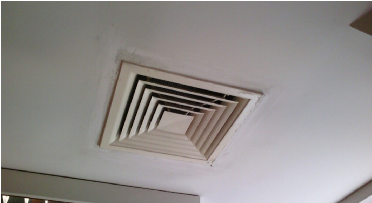
3. fénykép: Az irodaház egyik irodai befúvó anemosztátjának képe (Forrás: saját felvétel a Fornetti Kft. engedélyével)
