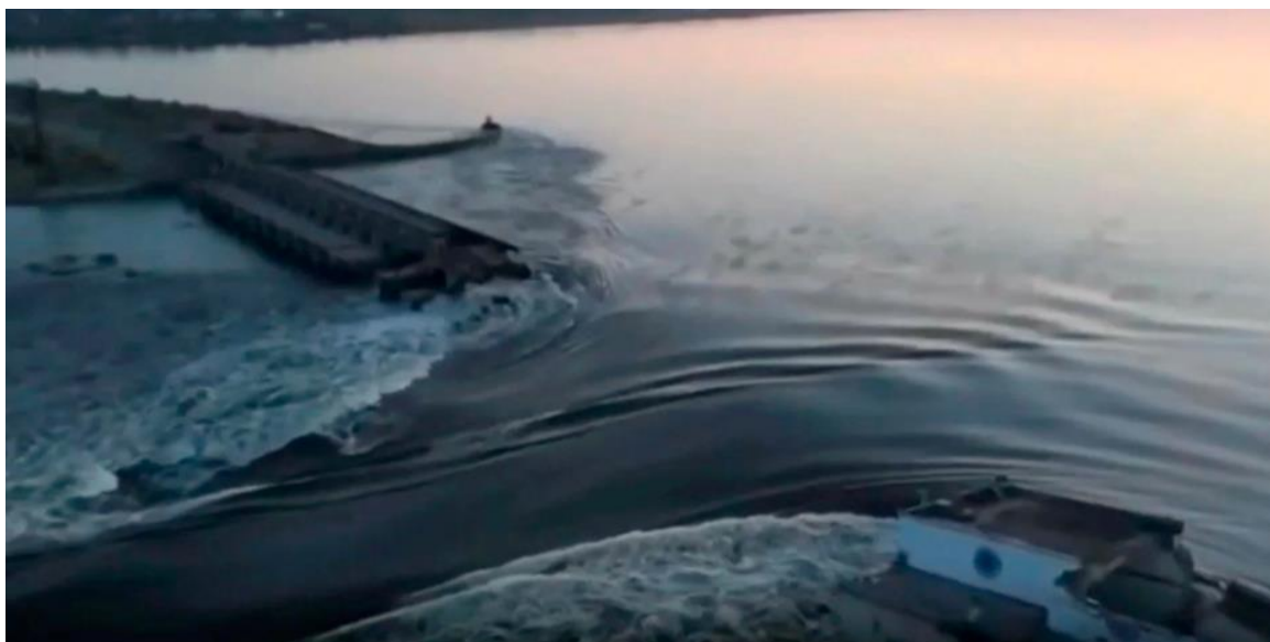
7. kép –Gátszakadás – kahovkai gát leomlása (Ukrajna)
